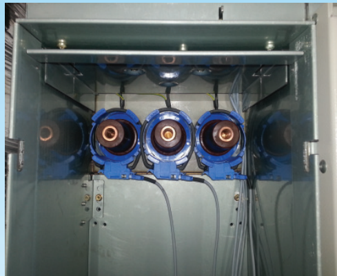
Ein Stromwandler-Typ für alle Trafogrößen; alternativ auf Durchführung oder auf Kabel montierbar
