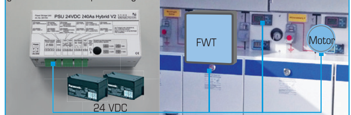
PSU-Hybrid Langzeit-Puffer Sekundärtechnik, Motoren in ferngesteuerten Knotenpunktanlagen
